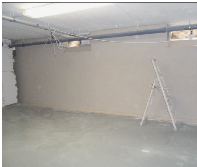
Zum Einsatz kam eine Kombination von Sanierputz und mineralischer Dichtschlämme. Die Bilder zeigen die Vorher-/Nachher-Situation. (Fotos: epasit)
