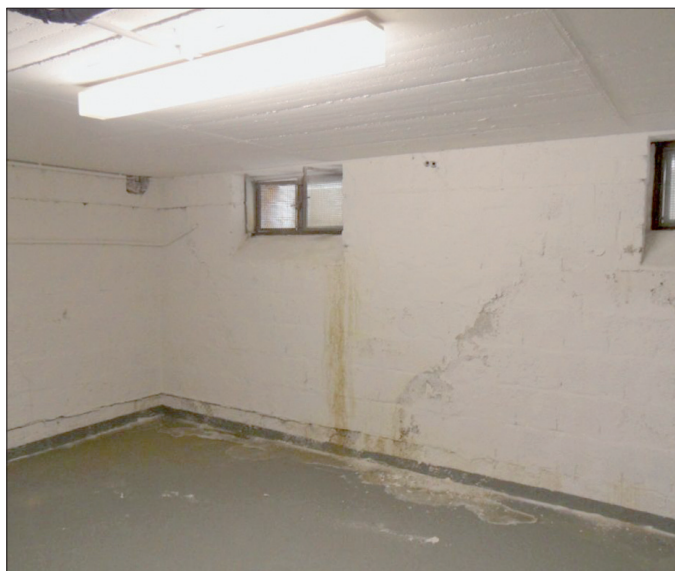
Zum Einsatz kam eine Kombination von Sanierputz und mineralischer Dichtschlämme. Die Bilder zeigen die Vorher-/Nachher-Situation. (Fotos: epasit)
