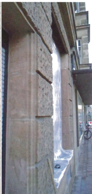
Die Oberfläche wurde mit unterschiedlich starkem Schleifpapier behandelt.
