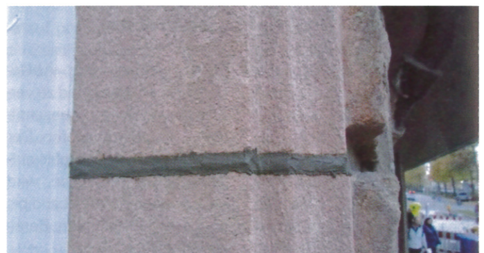
Die Fugen wurden aufgefüllt mit »epasit fsm« Fugensaniermörtel.
