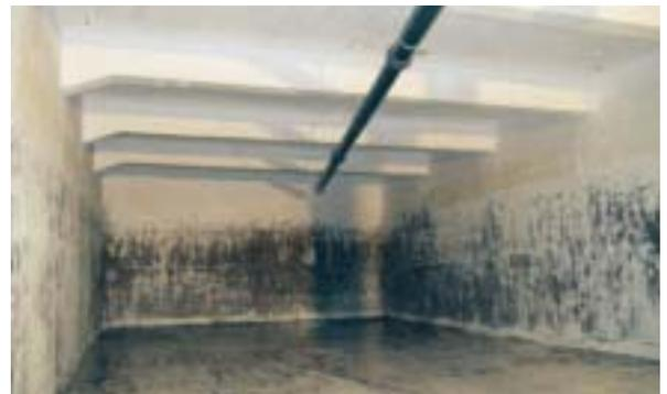
*Korrosionsschäden im Innern des Behälters waren durch Aufweichungen in der Beschichtung gut zu erkennen.*
