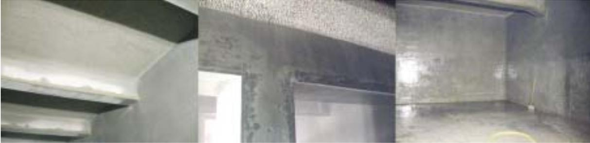
Fertig beschichtet: Decke mit Unterzügen, Wände und Boden.
