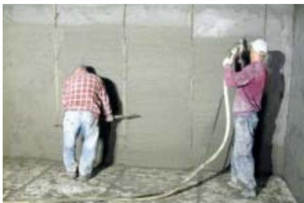
Die Beschichtung wurde in Spritztechnik aufgebracht.
