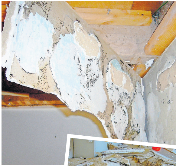
Schimmeliger Gipskarton unter den alten, schimmeli-gen Badkacheln. Hier ist eine Badsanierung ange-sagt. Fotos: Epasit
